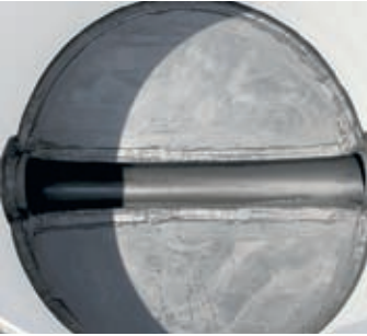
Фото 2. Вид прямопроходного лотка сверху
