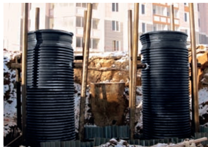
Фото 19. Монтаж корпусов КНС
