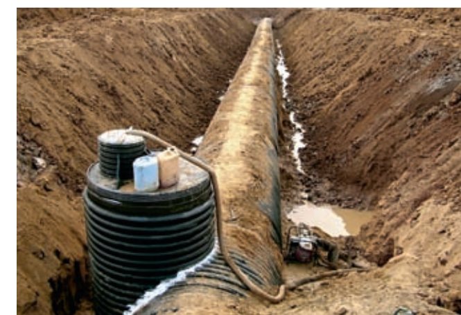
Фото 17. Тангенциальный колодец на коллекторе
