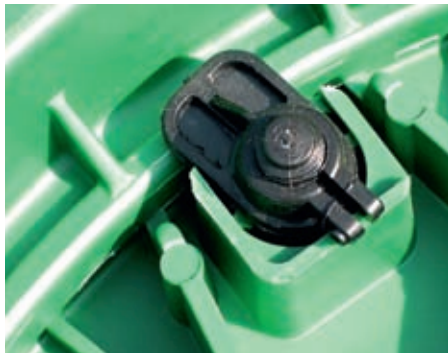
Фото 41. Запорное устройство люка (вид снизу)
