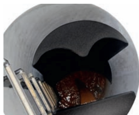
Фото 14. Обустройство перепадного колодца обеспечивает его обслуживание
