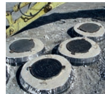
Фото 35. Пример использования формы для бетонирования
