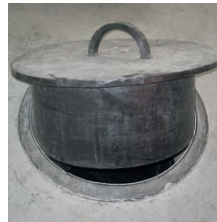
Фото 42. Сварная полиэтиленовая крышка
