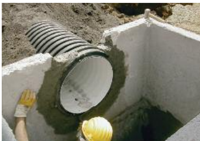
Рис. 30. Монтаж трубы КОРСИС в бетонном колодце
