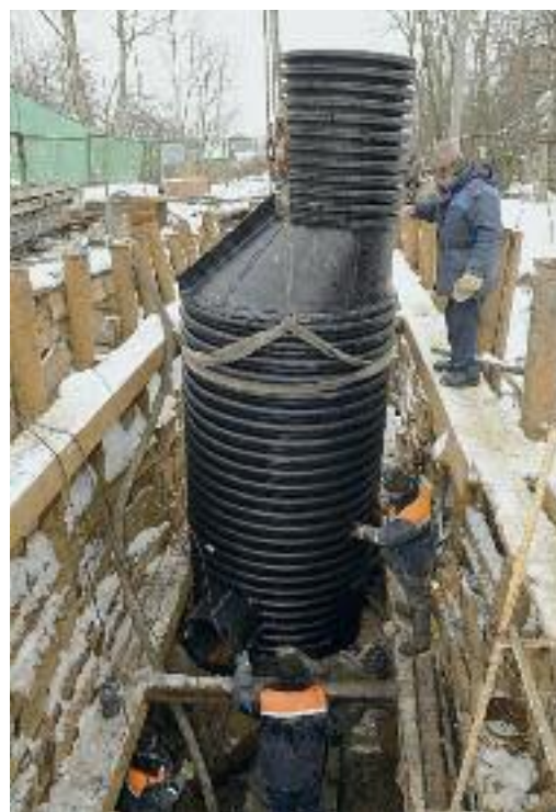
Рис. 27. Сварной прямопроходной колодец 1600 мм высотой 5,7 м
