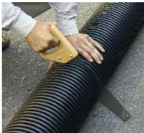
Рис. 18. Обрезка труб КОРСИС. Трубы КОРСИС отрезают перпендикулярно оси трубы по впадине гофра
