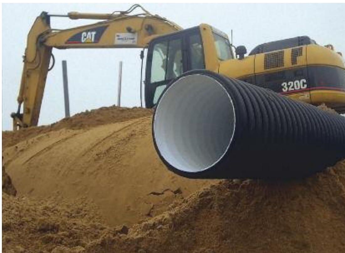
Рис. 1. Строительство трубопровода с применением труб КОРСИС
