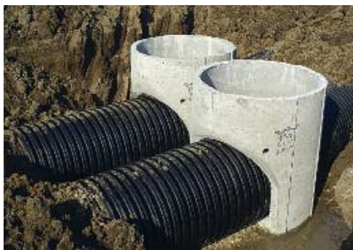
Рис. 31. Применение бетонных колодцев в системе труб КОРСИС
