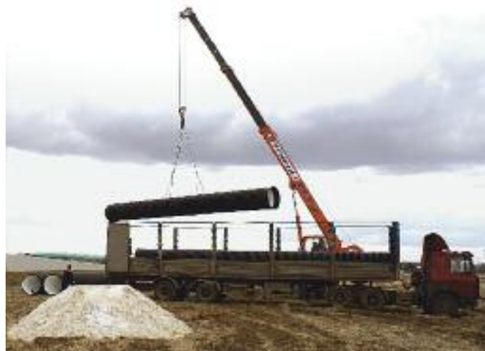
Рис. 38. Транспортировка труб КОРСИС
