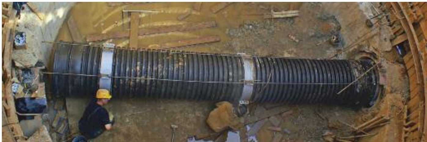
Рис. 19. Санация ж/б трубопровода с использованием трубы КОРСИС.
