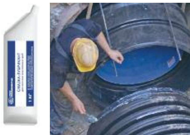
Рис. 16. Подготовка поверхностей для соединения
