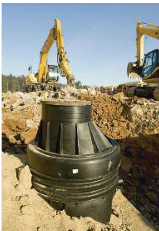
Рис. 26. Сборный колодец КОРСИС диаметром 1200 мм
