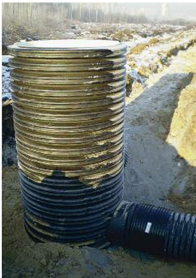
Рис. 28. Сварной угловой колодец КОРСИС
